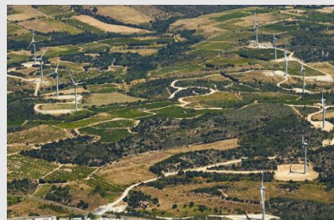
Parc éolien de FENOUILLEDES : Département : Pyrénées Orientales (66) Puissance électrique : 23,5MW 10 éoliennes Mise en service : novembre 2018
