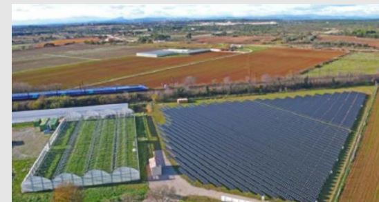
Centrale Solaire de LUNEL Département : Hérault (34) Puissance électrique : 500kWc Mise en service : Septembre 2008
